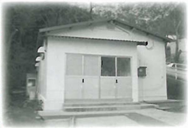
「改修後の写真」
