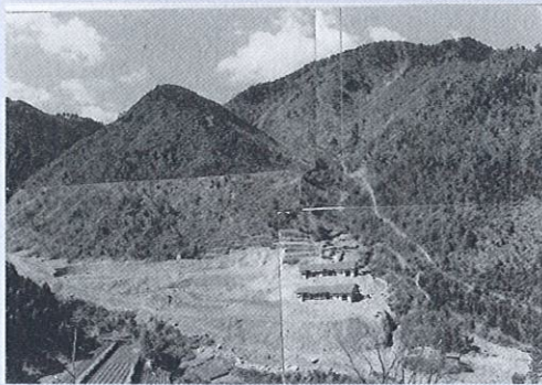
昭和34年建設中の学園
